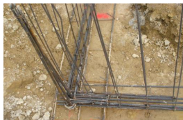
Nœud de chaînage - Continuité mécanique
